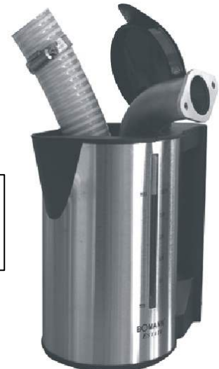
Fig. 22 : Réchauffement du raccord coudé et du tuyau
